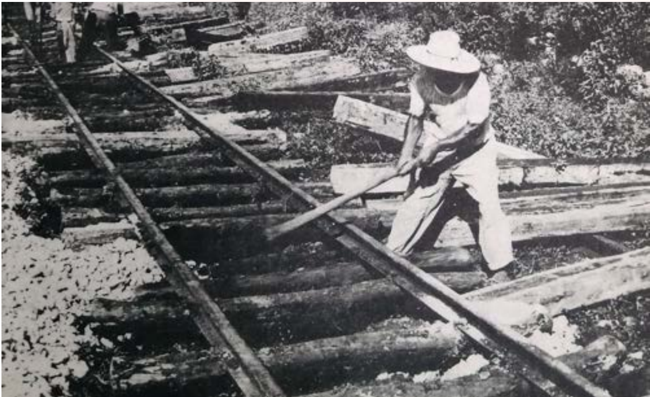
Trabajo a mano durante el ensanchamiento de vías Campeche-Mérida, entre 1957 y 1959 Fuente: Francisco M. Tognó, Anteproyectos Ferroviarios en la Frontera Sur de México, México, 1950. Documento en resguardo del Centro de Documentación e Investigación Ferroviarias (CDEF).
